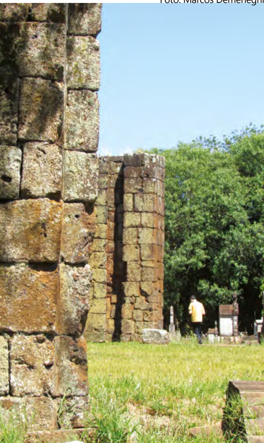
Igreja de São João Batista (aberturas laterais)
