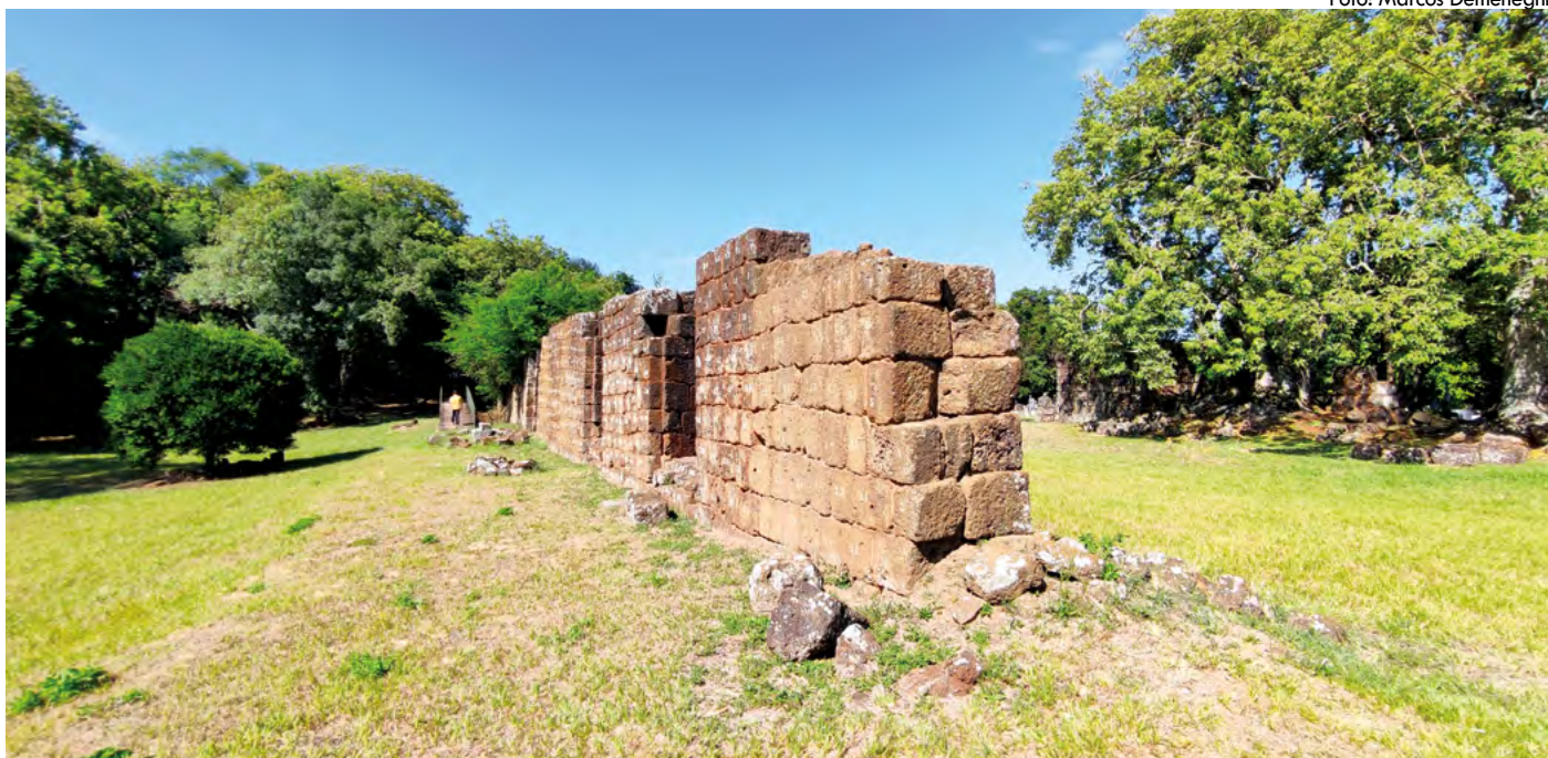
Parede divisória da Igreja e acesso à área do Pátio dos Padres. Passarela ao fundo dá acesso aos cômodos e também à Quinta
