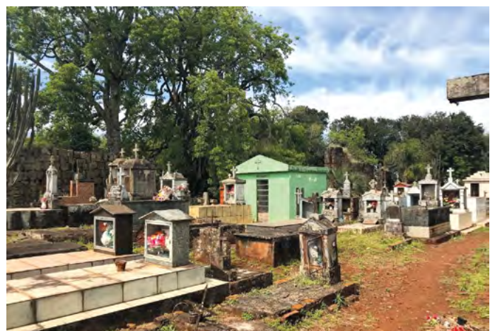
Parte da parede onde era a capela mortuária ao lado do cemitério
