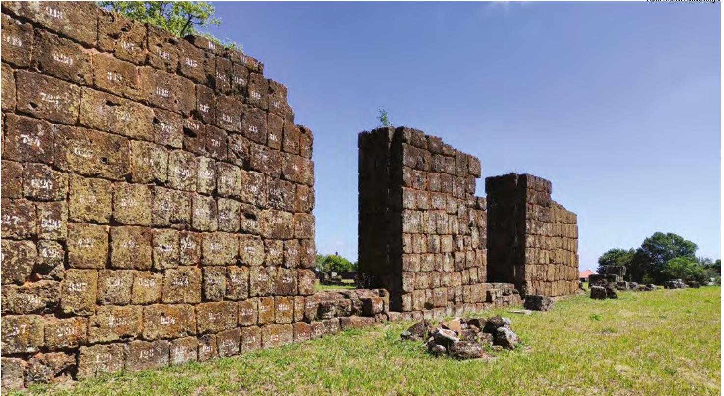
Aberturas laterais nas paredes da antiga igreja de São João Batista
